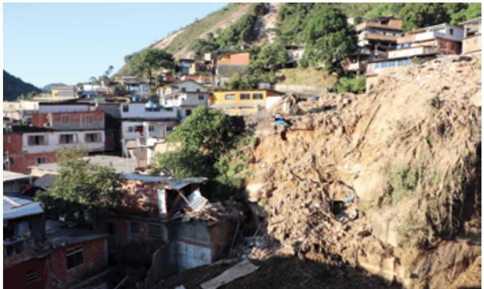
Área do Morro da Oficina em que uma encosta desabou: dezenas de moradores foram evacuados do local por conta do risco de novos deslizamentos
